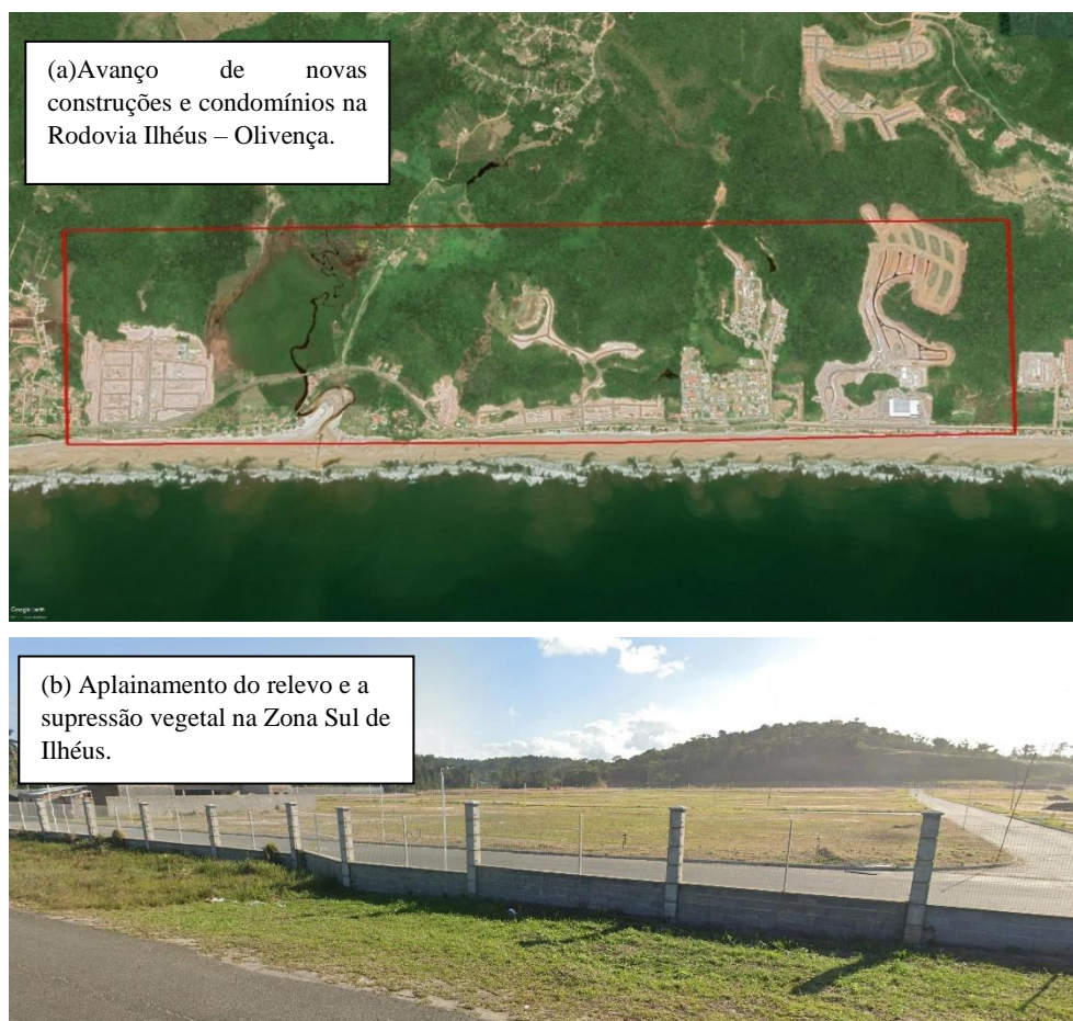
Figura 5 - Imagem aérea (a) e frontal (b) do avanço urbano na rodovia Ilhéus - Olivença
