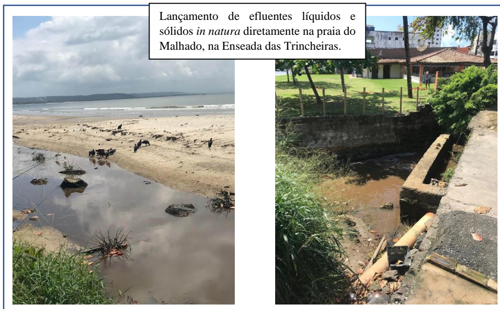
Figura 3 – Despejo de esgoto doméstico na praia do Malhado, Ilhéus - Bahia
