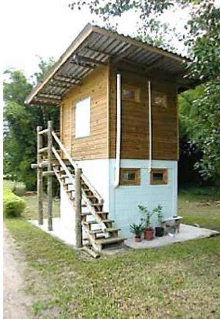
Figura 7 – Estrutura de um banheiro seco localizado em Florianópolis - SC.
