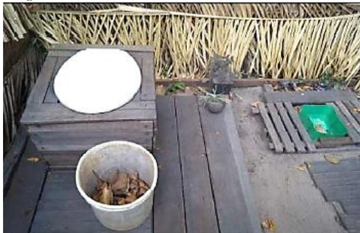
Figura 8 – Banheiro seco localizado no interior da Amazônia.
