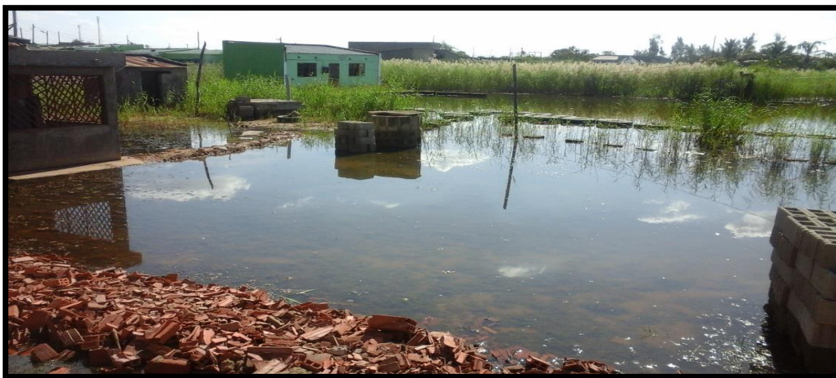
Figura 3. Casas erguidas nos cursos de água, Bairro de Nkobe.
