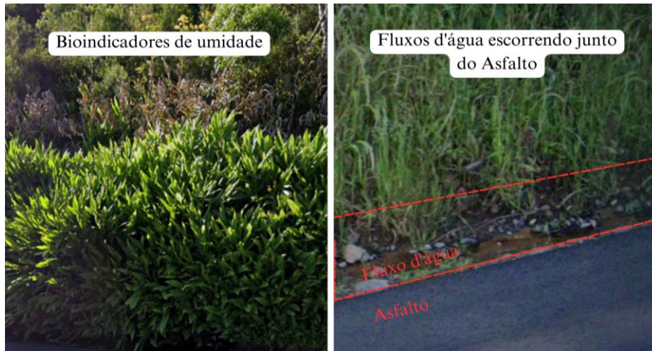
Figura 6 – Imagens dos Bioindicadores de umidade e dos Fluxos d'água ao lado do asfalto Figure 6 - Images of the Bioindicators of humidity and Water Fluxes alongside the asphalt
