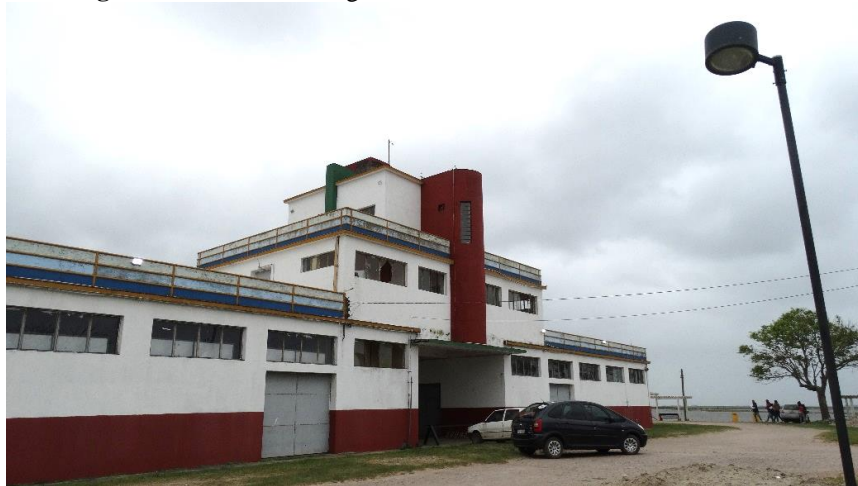
Figura 6 – Prédio do antigo cais do Porto de Santa Vitória do Palmar.
