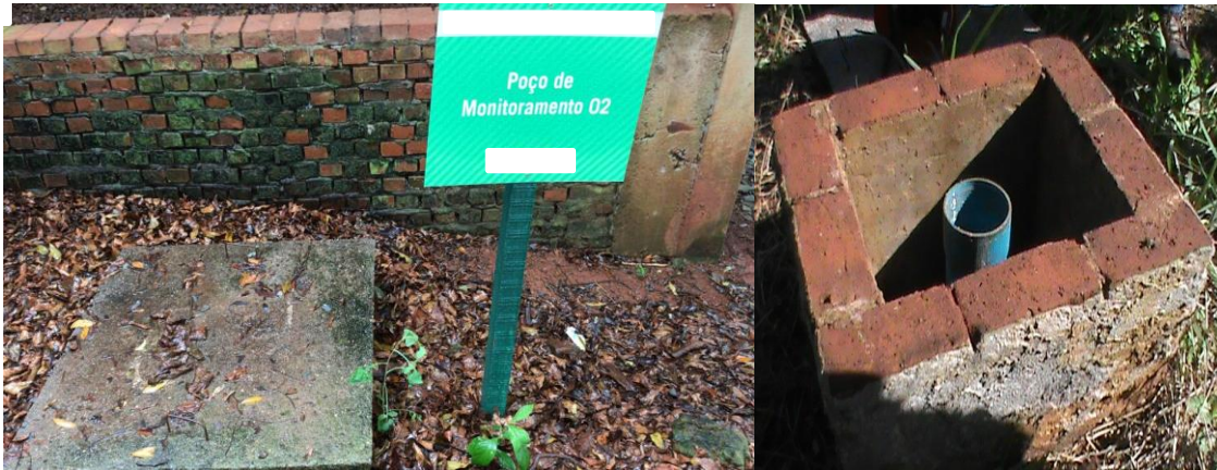
Figura 5 - Poços de monitoramento de água subterrânea.
