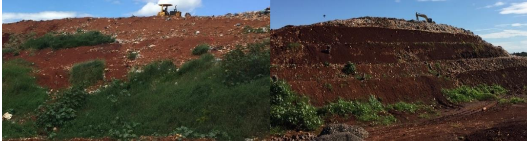
Figura 8 - Acomodação, compactação e recobrimento dos rejeitos.
