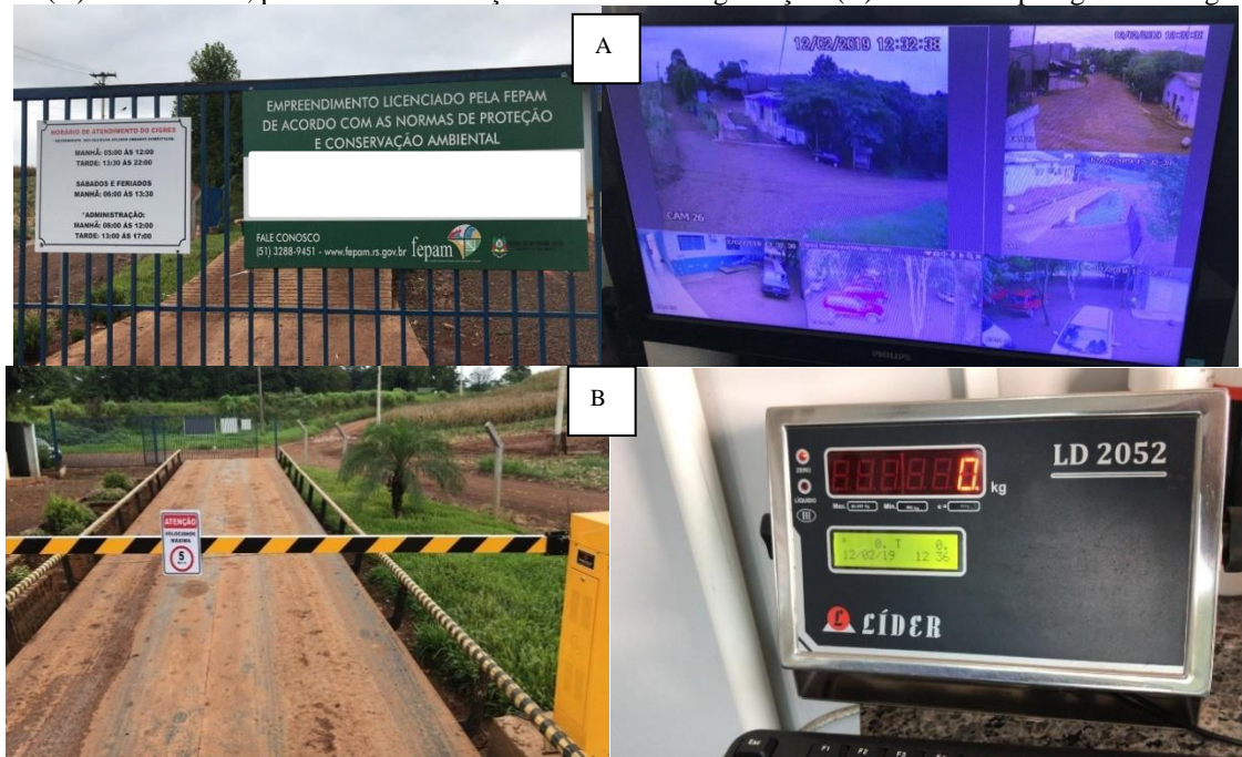
Figura 3 - (A) Limite físico, placas de identificação e sistema de segurança e (B) Sistema de pesagem e cubagem.
